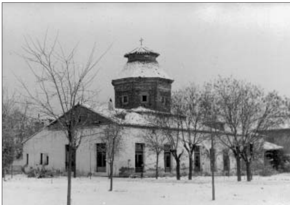
Casa de la Torre.
